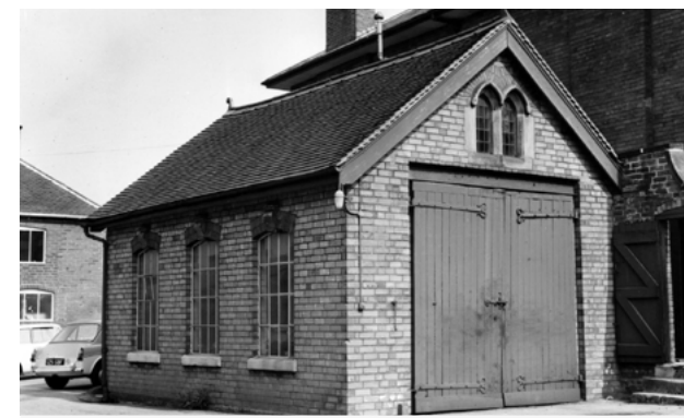
Budova JCB z roku 1945
