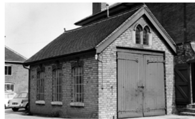
Budova JCB z roku 1945
