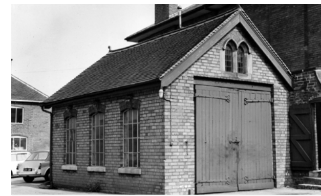
Budova JCB z roku 1945
