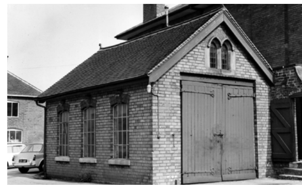
Budova JCB z roku 1945
