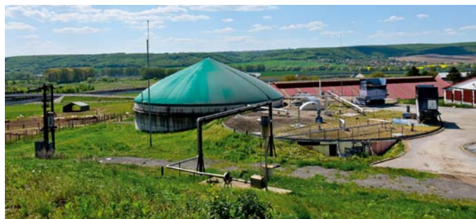
Bioplynová stanica má dve kogeneračné jednotky s výkonom 600 a 400 kWh.
